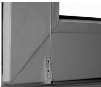
Рис. Установленный кронштейн без крышки
